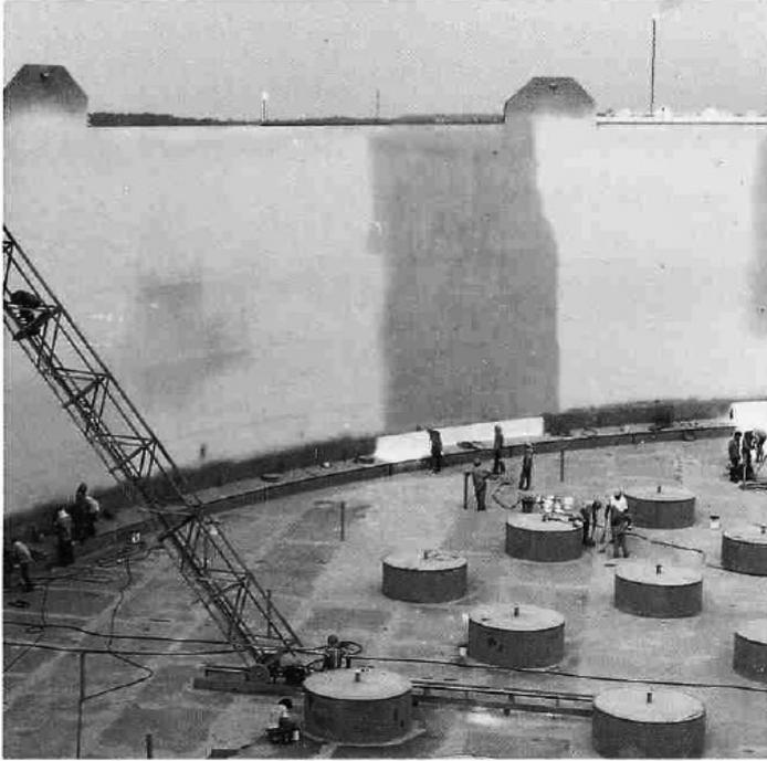
Adicionalmente se colocan las boyas, los soportes de la cúpula flotante durante las etapas de mantenimiento, los drenajes de agua pluvial, la escalera rodante, el tubo-sello y demás accesorios necesarios para asegurar un buen funcionamiento durante la operación, incluyendo un sistema contra incendio.
