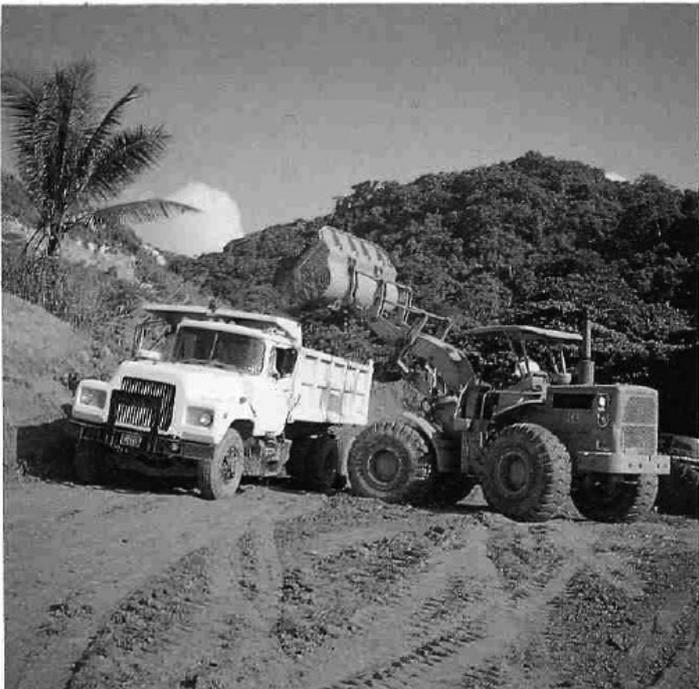
Derecha, construcción del canal de descarga en la laguna de clarificación; izquierda, excavación para el desplante del estribo izquierdo de la presa.
